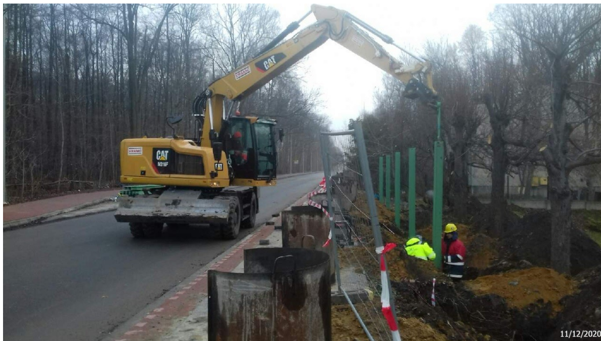
Zdjęcie nr 1: Roboty drogowe – montaż słupów ekranów akustycznych na DW 913
