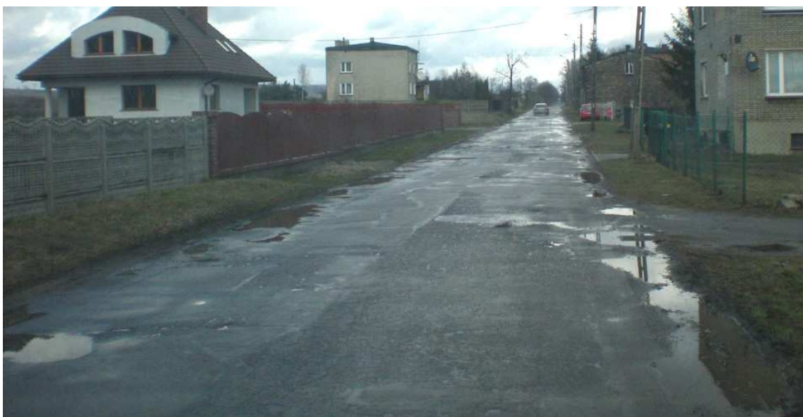
Rys. 3.1 Łaty, spękania, deformację przekroju poprzecznego, zastoiska wodne
