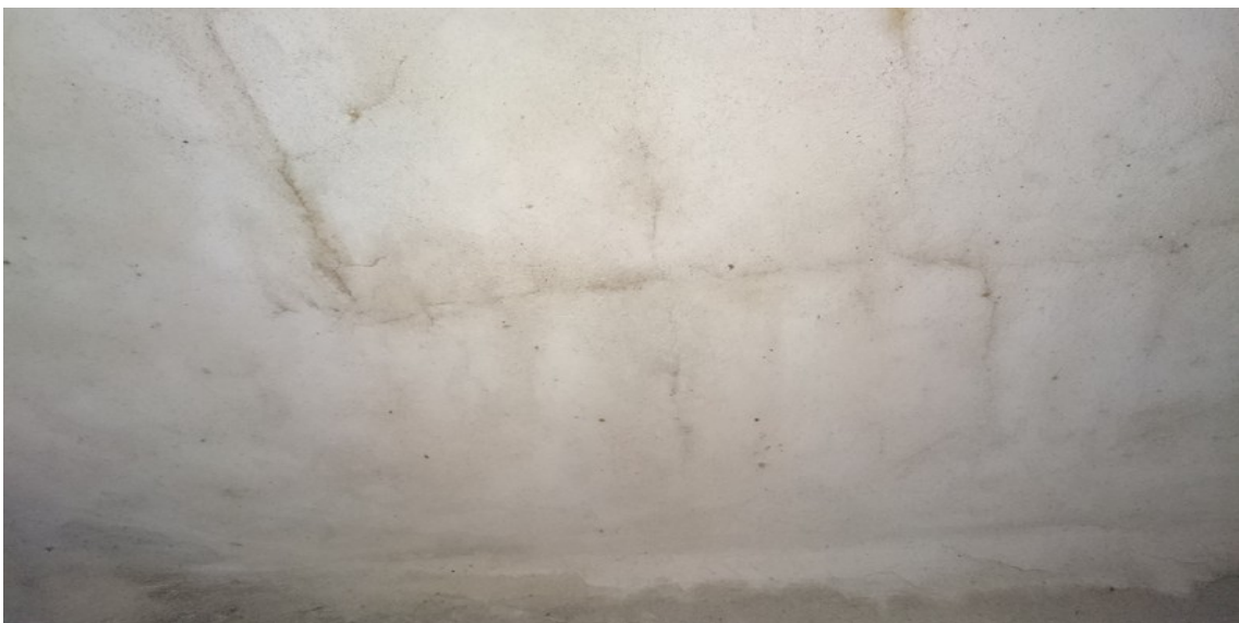
Fot. nr 13 Strop żelbetowy nad drugim piętrem( cz. nadbudowana). Na zdjęciu widoczne są pęknięcia i zarysowania płyty stropu żelbetowego
