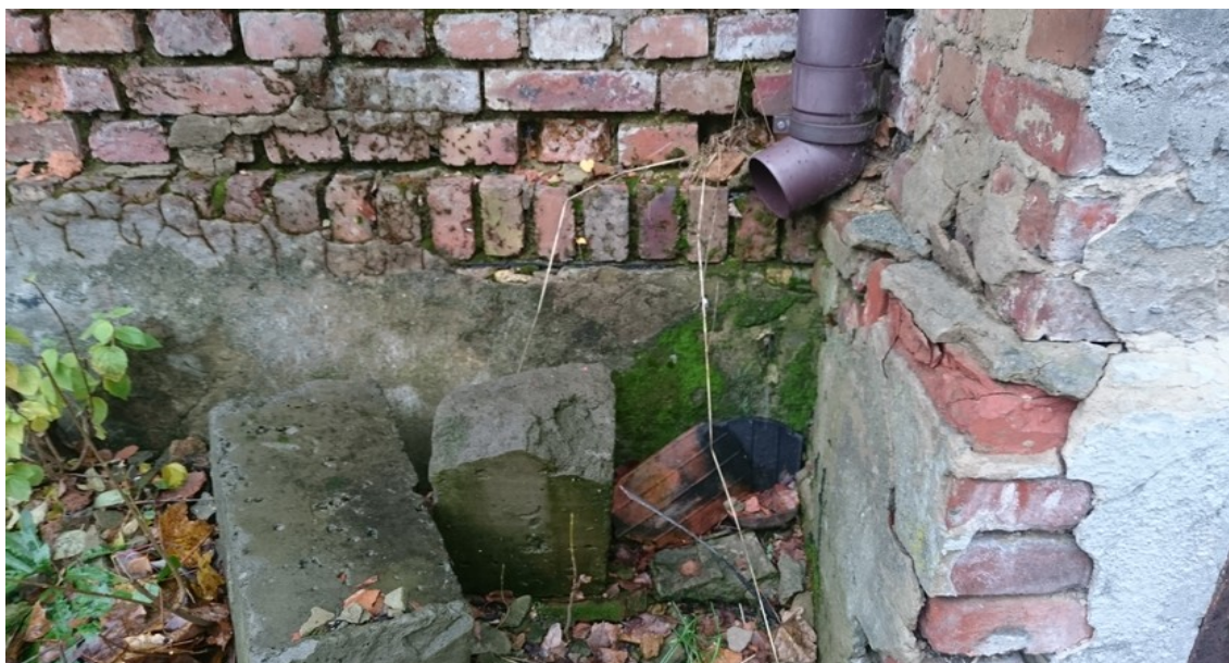
Fot. nr 5 Zdjęcie pokazuje stan murów fundamentowych zewnętrznych (w obrębie rur spustowych)
