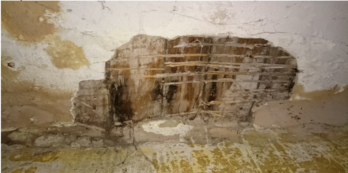
Fot. nr 10 Zdjęcie pokazuje odkrywkę (od strony podłogi piętra) stropu Acermana nad parterem.
