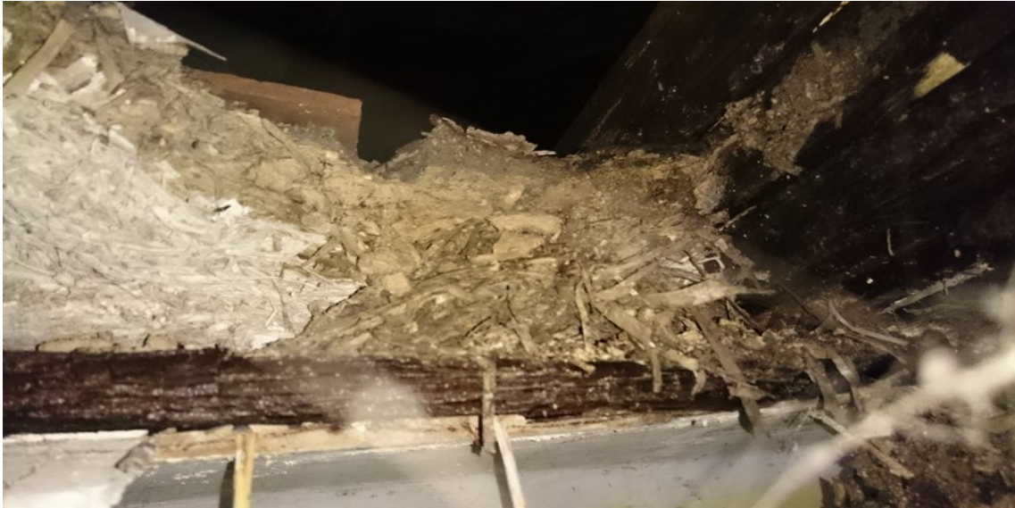
Fot. nr 12 Fotografia pokazuje stan zniszczenia stropu drewnianego. Jak widać ociepleniem stropu od strony strychu jest suprema( płyty wiórowo-cementowe)
