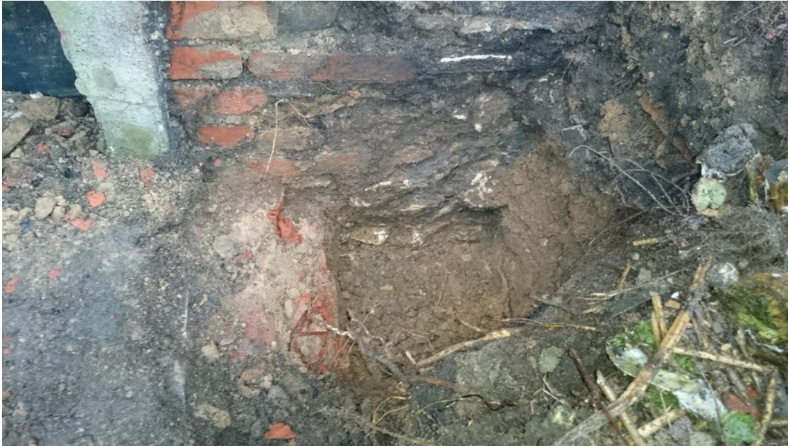
Fot. nr 3 Zdjęcie pokazuje ścianę fundamentową z kamienia wapiennego oraz brak izolacji bitumicznej ścian w części podpiwniczonej
