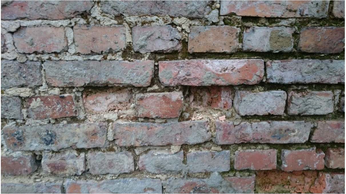
Fot. nr. 7 Widok elewacji ściany zewnętrznej. Na zdjęciu widać ubytki w strukturze cegieł ściany.
