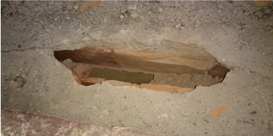
Fot. nr 10 Zdjęcie pokazuje odkrywkę (od strony podłogi piętra) stropu Acermana nad parterem.
