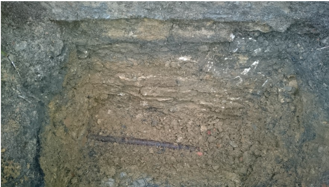
Fot. nr 3 Zdjęcie pokazuje ścianę fundamentową z kamienia wapiennego oraz brak izolacji bitumicznej ścian w części podpiwniczonej
