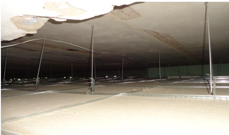
Zdj. 1. Ubytki w stropie stropodachu.
