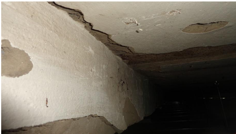
Zdj. 3. Odspojenie stropów stropodachu.
