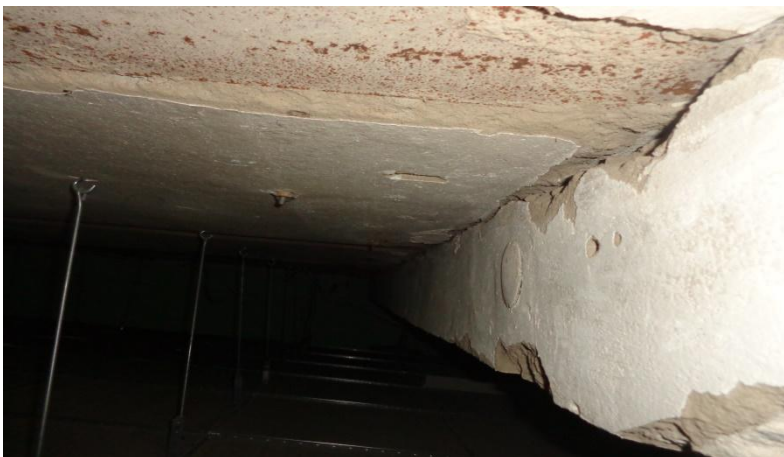
Zdj. 2. Pęknięcia w miejscu połączenia stropów stropodachu.
